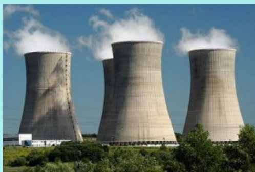
Obrázek č. 3 Jaderná elektrárna Mochovce
