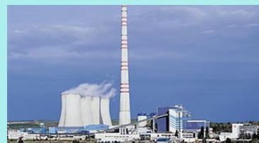
Obrázek č. 2 Tepelná elektrárna Tušimice
